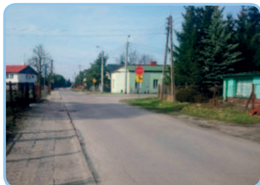
Ul. Pomorska przed przebudową.
