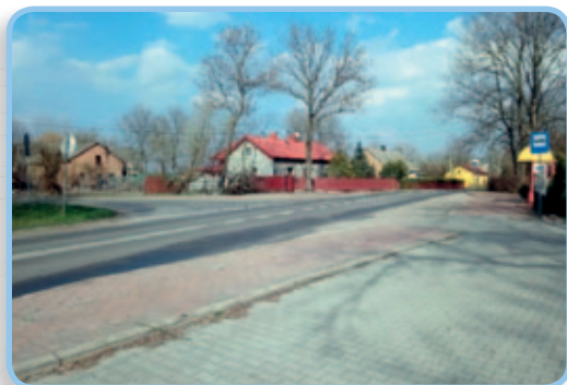
Skrzyżowanie dróg powiatowych 1509W i 1510W przed rozbudową.
