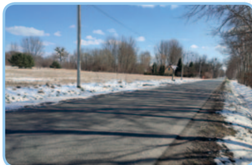
Droga nr 1514W w m. Budy Zosine po modernizacji.
