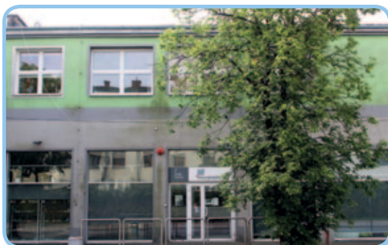
Budynek Publicznego Ogniska Plastycznego w Grodzisku Mazowieckim.
