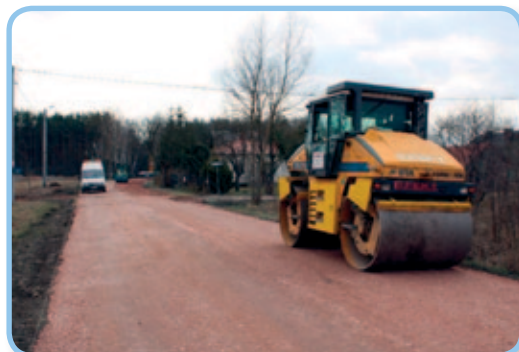
Trwające roboty na ul. Paprociowej w Opychach.
