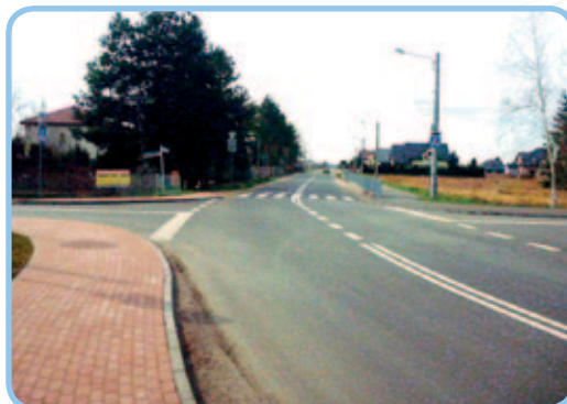
Droga nr 1507W w miejscowości Boża Wola po rozbudowie.
