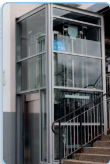
Szyb dźwigowy zewnętrzny przy budynku Starostwa Powiatu Grodzkiego przy ul. Dalekiej 11A w Grodzisku Mazowieckim.
