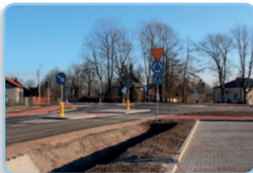
Skrzyżowanie dróg powiatowych 1509W i 1510W po rozbudowie.
