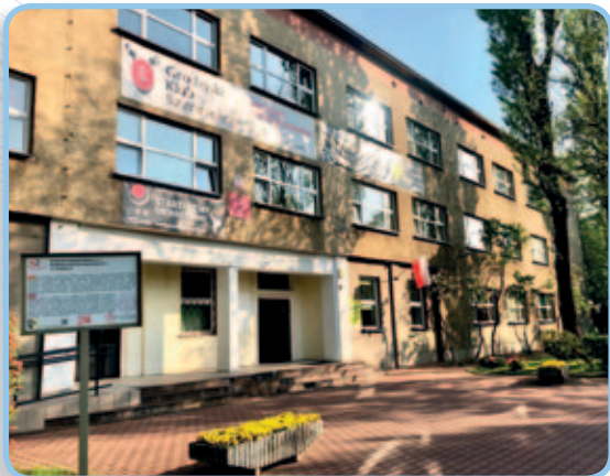
Budynek Zespołu Szkół nr 1 w Milanówku.
