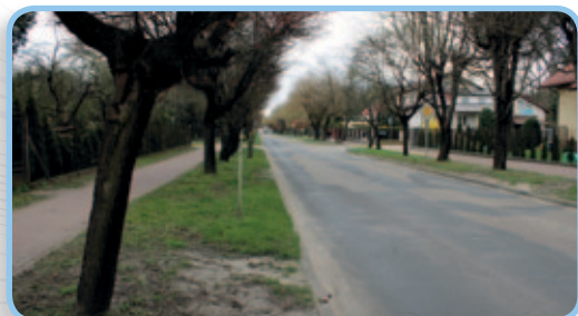
Ul. Brwinowska w Podkowie Leśnej przed remontem.
