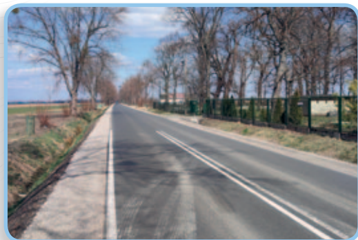
Droga nr 1507W po remoncie.
