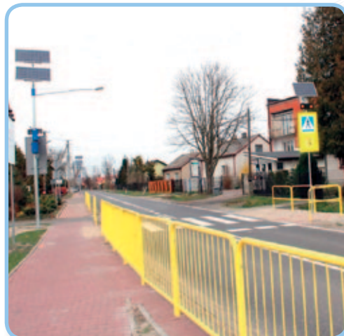
Przejście dla pieszych na ul. Armii Krajowej w Baranowie.
