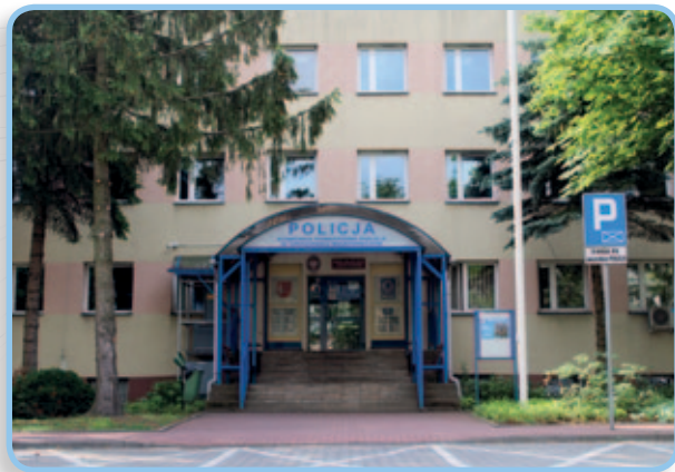
Budynek Komendy Powiatowej Policji w Grodzisku Mazowieckim.
