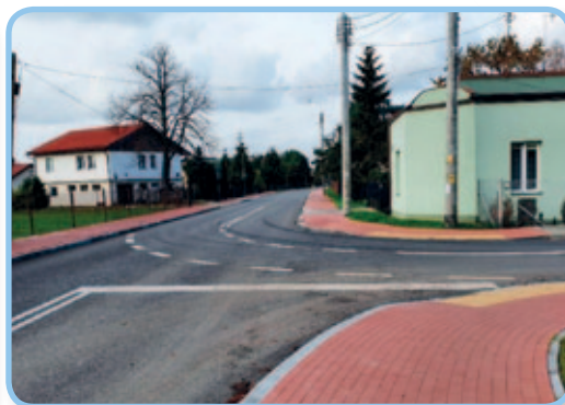
Ul. Pomorska w Jaktorowie po przebudowie.
