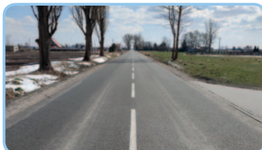
Droga nr 1507W w m. Izdebno Kościelne.
