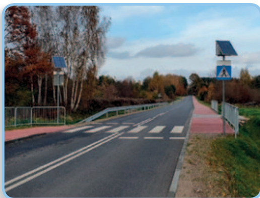
Droga powiatowa nr 1504W po rozbudowie.
