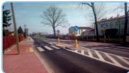
Ul. Królewska w Kaskach po przebudowie.
