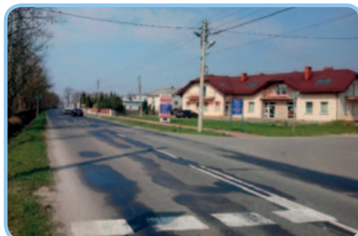
Droga powiatowa nr 1503W przed rozbudową.
