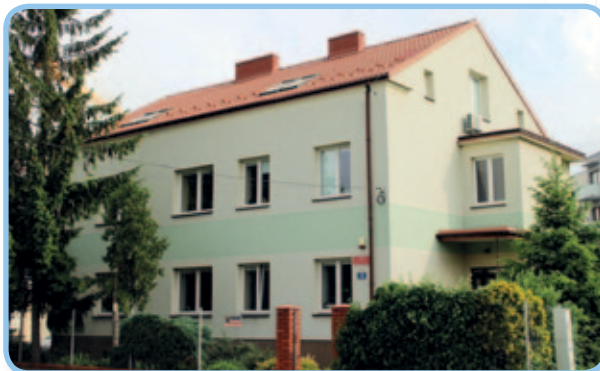
Budynek Poradni Psychologiczno-Pedagogicznej w Grodzisku Mazowieckim.
