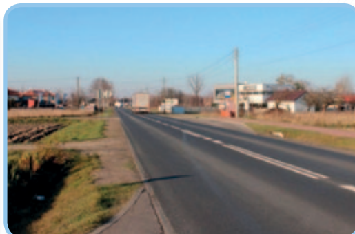
Droga powiatowa nr 1503W po rozbudowie.
