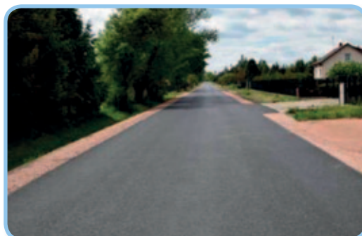
Droga nr 1519W w m. Kaleń po remoncie.
