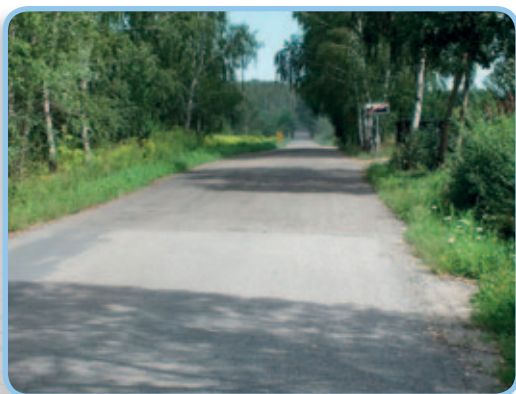
Droga powiatowa nr 1504W przed rozbudową.
